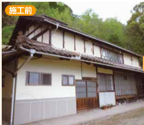
外壁に本焼スギ板を使用、屋根は石州瓦葺 ▶
