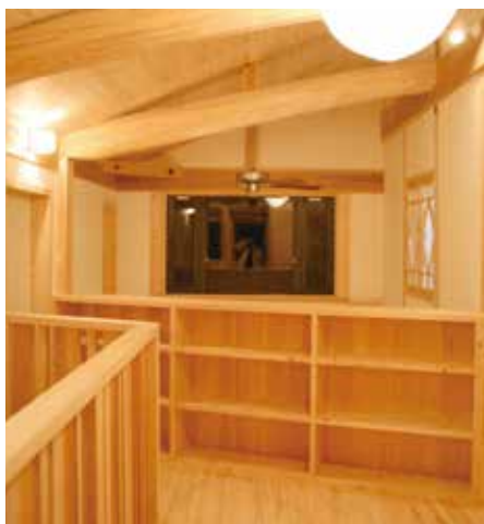
ヒノキフローリング、スギ板天井、地マツ化粧梁
