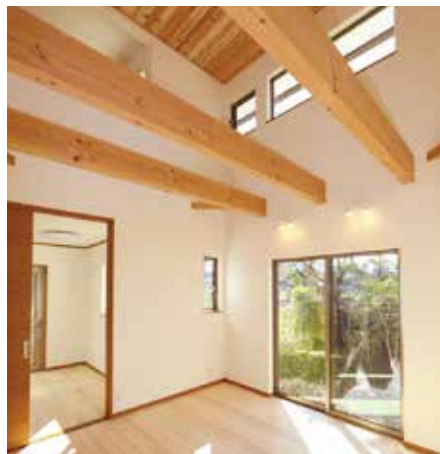
天井にはスギを、梁は地マツ、フローリングにはヒノキを使用
