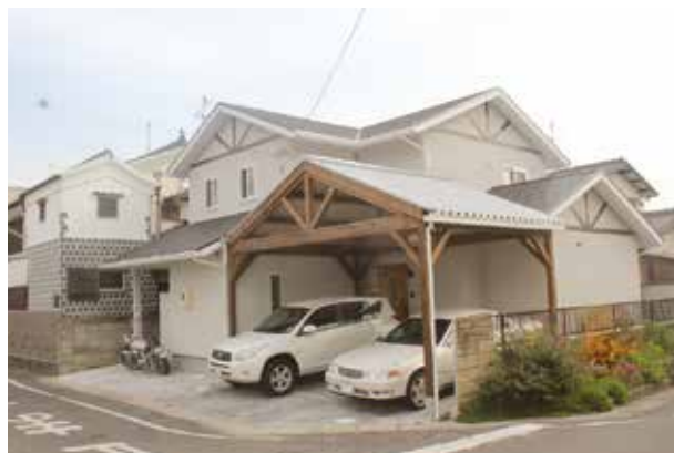
12cm角ヒノキ材を重ねて使用した木製ガレージ
