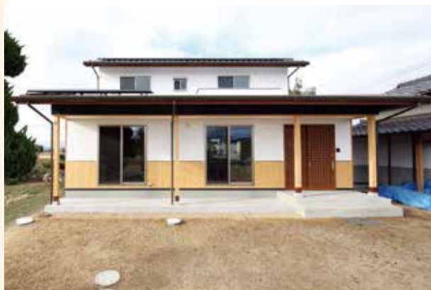
ヒノキの柱とスギ板を腰壁に使用
