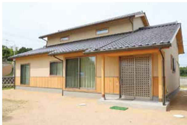
ヒノキの柱とスギ板を天と腰壁に使用
