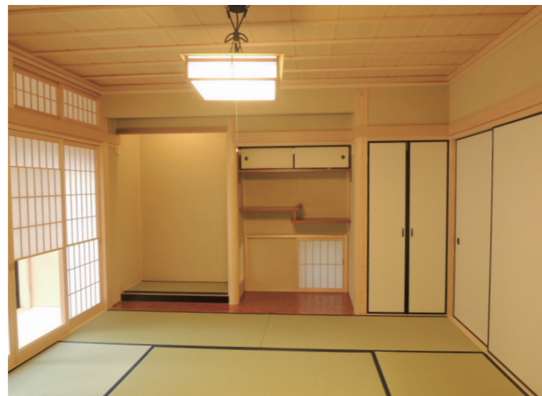
床柱は絞丸太、ヒノキ柱・長押等
